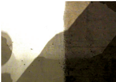
7. Stena suterénu po obnove: V ľavej časti obrázka vidíme aplikovaný termonáter. Stena v tejto časti je suchá, a na dotyk príjemne teplá. Tá istá stena v pravej časti obrázka je v pôvodnom stave – vlhká, studená a porastená riasami. Kaštieľ Báruczayovcov, Košice, august 2016. Foto: autor.
