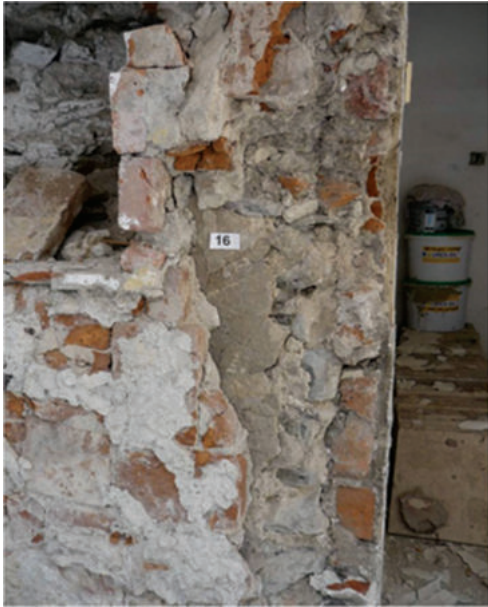
1. Položka č. 16 označuje staršiu – renesančnú omietku na kamennom murive, na ktorej je nanesená typická baroková tehlová plentáž. Hlavná ulica Košice, júl 2015. Foto: autor.
