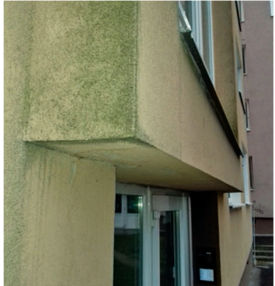
13, 14. Viditeľná degradácia kontaktného zatepľovacieho systému kolóniami húb, cyanobaktérií a rias. Bytový dom, Mestská časť Košice-Západ, 2017. Foto: autor.
