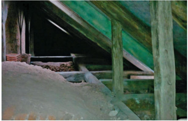
2. „Vzorne“ obnovený krov kultúrnej pamiatky – avšak už bez násypu na klenbách..., meštiansky dom, Alžbetina ulica, Košice, december 2015. Foto: autor.
