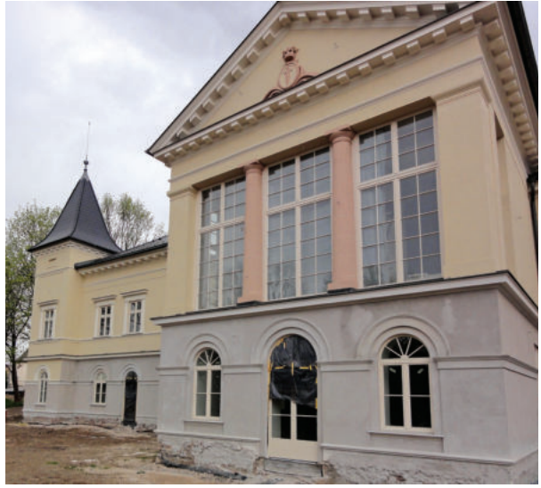
5. Kaštieľ Bérczayovcov v priebehu obnovy, Košice, august 2016. Horná časť budovy nad kordónovou rímsou je reštaurovaná a zateplená termonáterom. Nájdí rozdiel... (rozuzlenie hádanky: pribudol náter hrubý 1 mm). Foto: autor.
