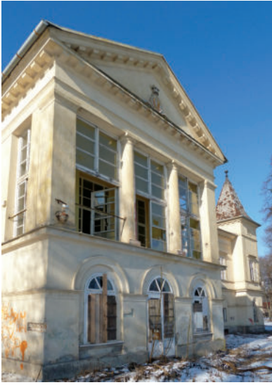
4. Stav kaštieľa Bérczayovcov pred obnovou, Košice, január 2012. Foto: autor.
