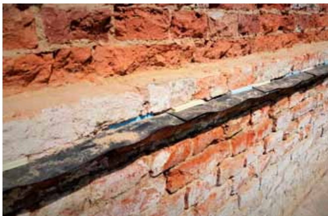
Podřezání zdiva řetězovou pilou je jednou ze základních mechanických metod sanace. stavimbydlim.cz
