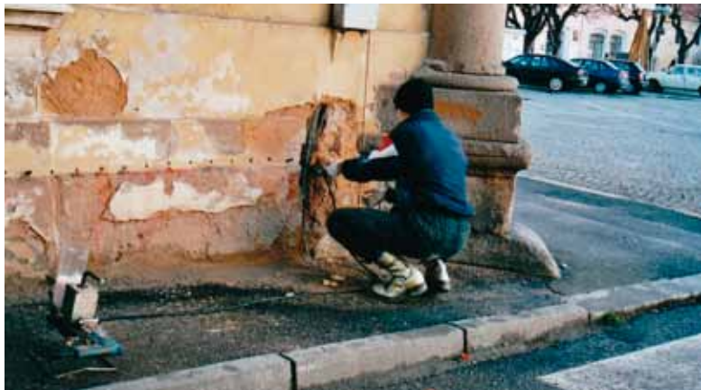
Vodorovná injektáž historického zdiva v Plzni silikonovou mikroemulzí. ezksanacestaveb.com
